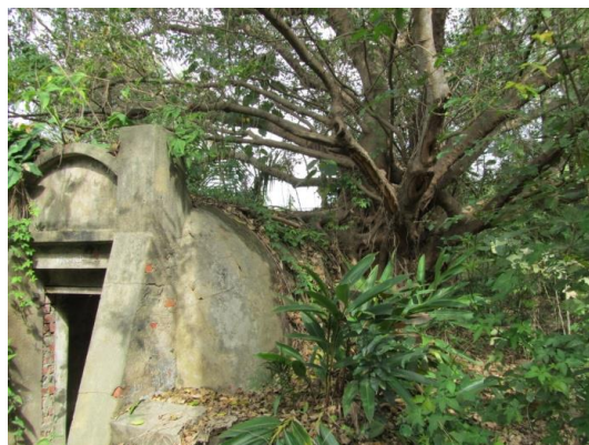
歷史建築永康三崁店糖廠防空洞群-9 號防空洞
