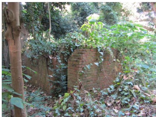
歷史建築永康三崁店糖廠防空洞群-1 號防空洞
