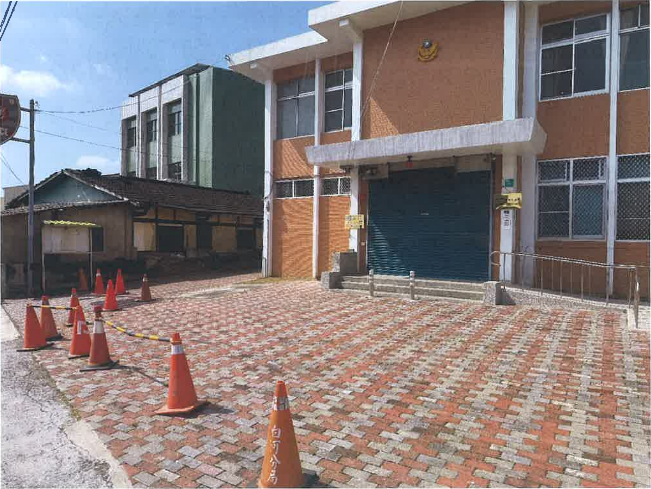
案件舉例照片-菁寮派出所(拍攝日期 2024/10/6)
