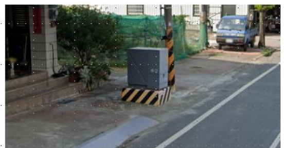
道路側溝位於人行道上
