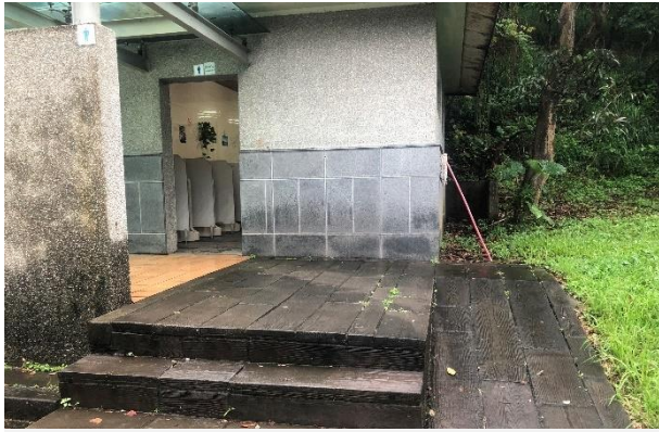
廁所 A 現況照片
