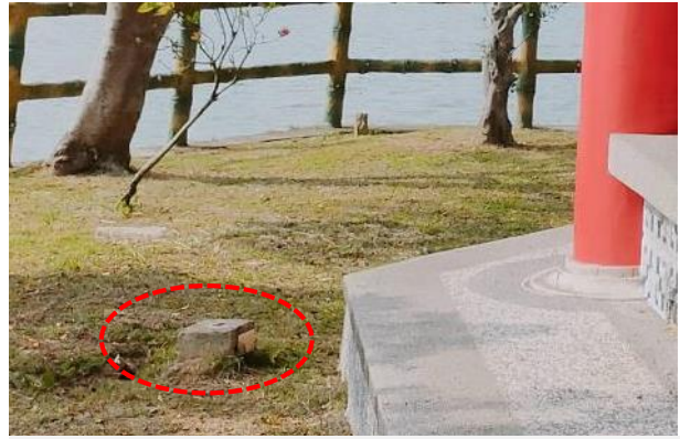
虎月亭周邊燈具已損壞
