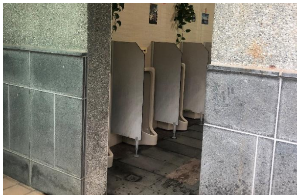
廁所 E 現況照片
