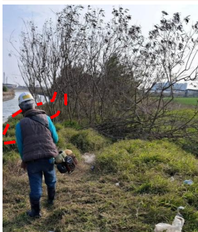
施工便道採人力整理
