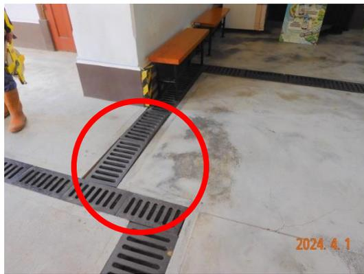
▲圖 5：線溝隔柵踏板間隔過大
