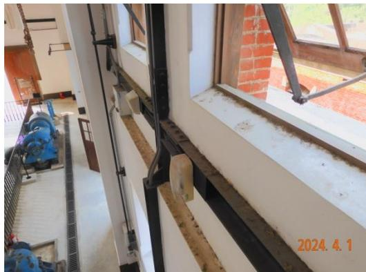
▲圖 7：鋼構補強之鋼件污垢
