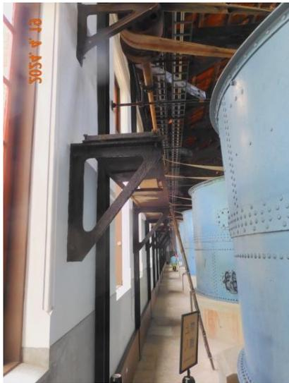
▲圖 3：鋼構補強之鋼件污垢
