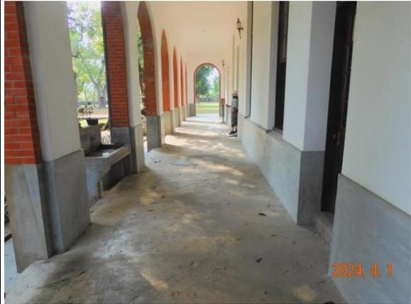
▲圖 4：辦公廳及檢驗室外面廊道粉刷層膨拱裂縫
