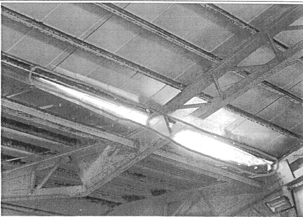
照片說明：屋頂水槽破裂
