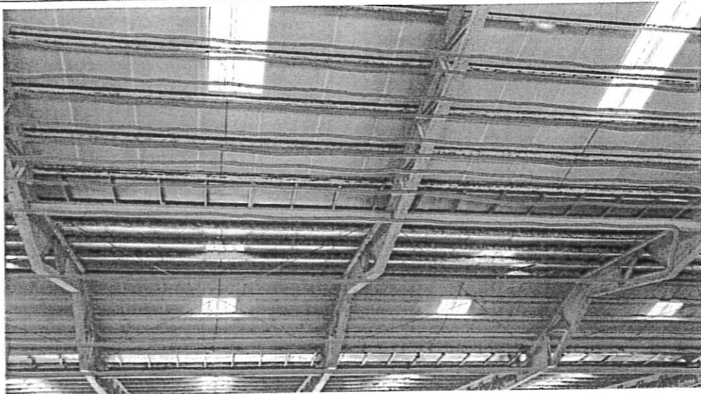
照片說明：鋼柱鏽蝕
