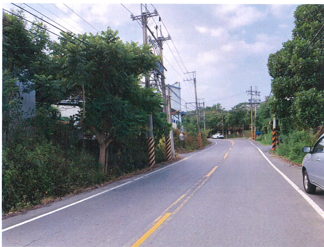
鹽水溪北新橋鄰近道路之現況
