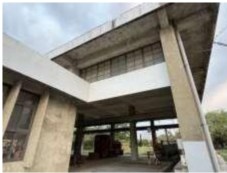
圖 1 蕭壠機關倉庫現況
