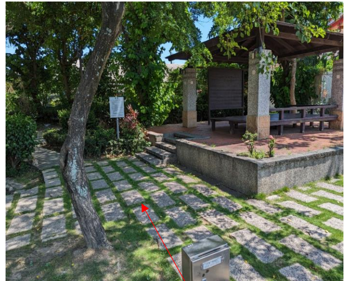
4 涼亭周圍步道為石板鋪面，車輛通行不易，施工動線受阻
