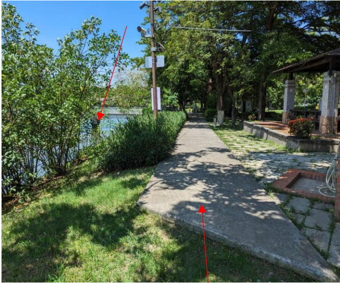
1 涼亭周圍步道為 3.5 噸貨車通行 (涼亭前方；水泥鋪面；鄰近水域)
