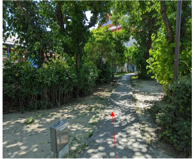
2 涼亭周圍步道為 3.5 噸貨車通行 (涼亭後方；水泥鋪面)
