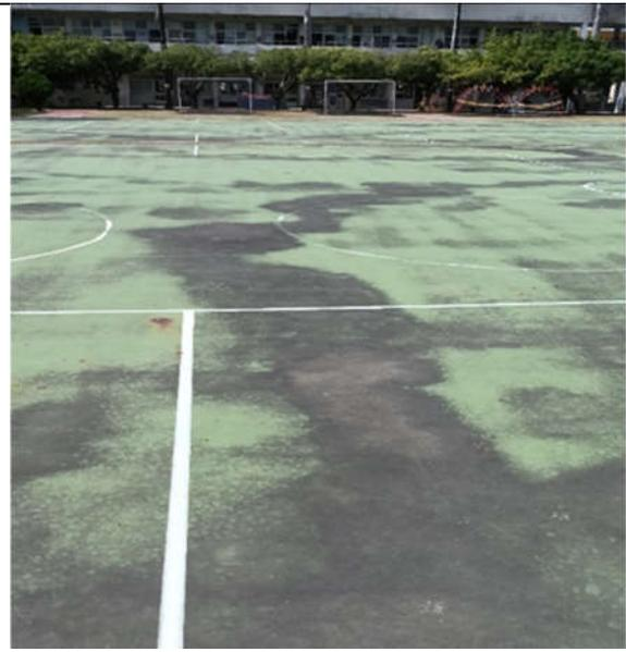
說明：中庭球場使用年限超過40年，地勢低窪，雨後易積水，加上排水不良，致使鋪面壞損嚴重，地面斑駁，對學生運動安全造成威脅
