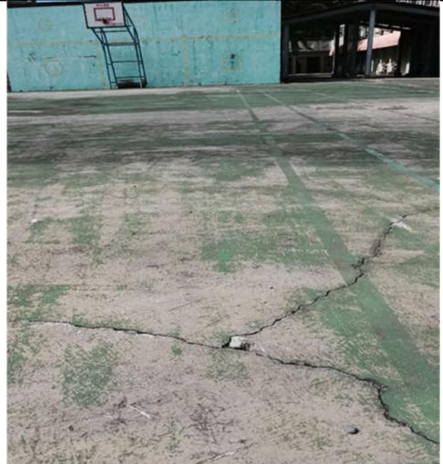
說明：南側綜合球場使用年限超過40年，地面龜裂破損，鋪面剝落，凹陷多處對學生的運動安全造成極大威脅，加上籃球架老舊，已不符修繕成本，應予以汰換。
