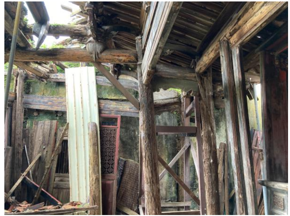
照 10：正廳內棟架目前局部設置暫時性支撐架。
