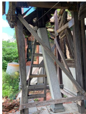
照 12：正廳前步口明間右架現場已設置暫時性支撐框架。
