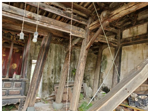
照 3：前步口明間桁樑斷落、看架崩塌木構件掉落、木柱與洗石子柱有嚴重傾斜狀況。
