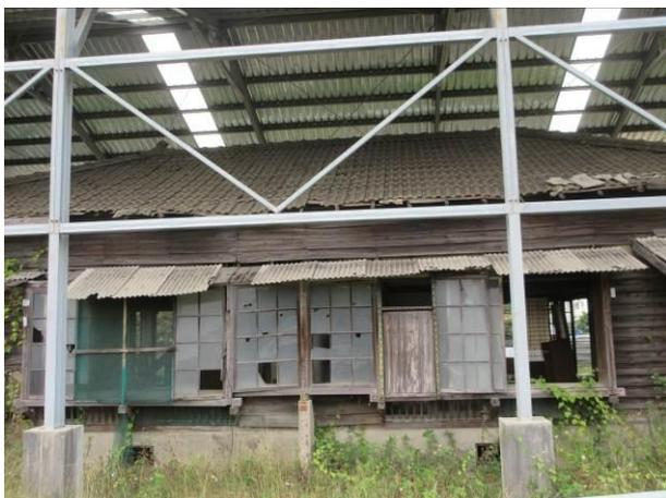
圖 5 屋面及屋身多處破損
