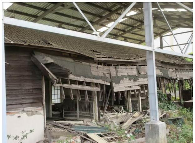
圖 6 屋面沉陷、屋身多處崩落
