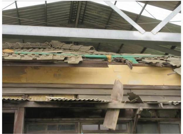
圖 4 宿舍群屋瓦多處破損
