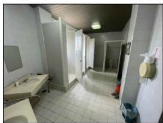
女廁現況照片
