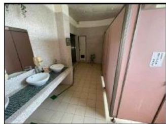
女廁現況照片
