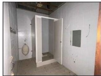
後側廁所現況照片
