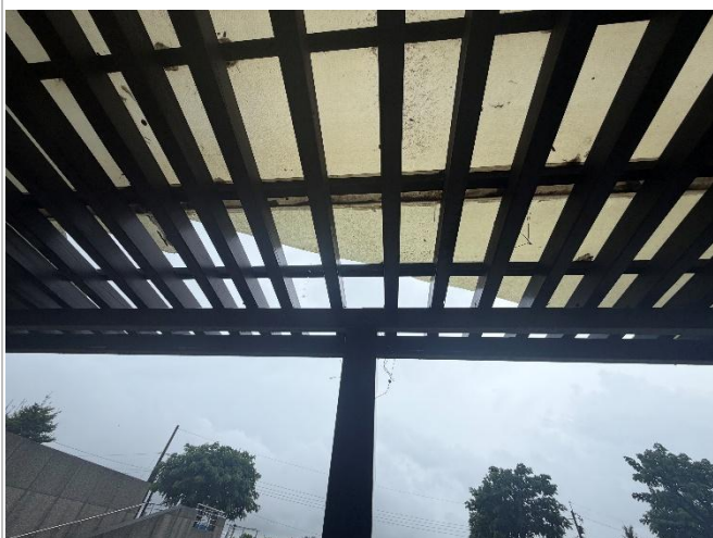
新營福園景行廳前方遮雨棚破損嚴重
