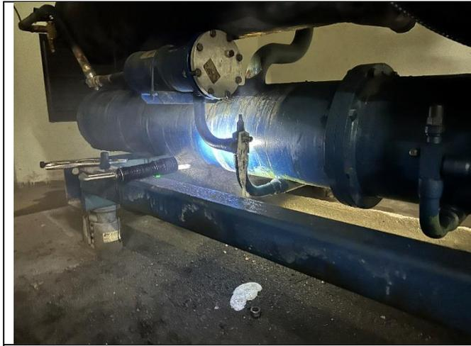
冰水主機蒸發器漏油
