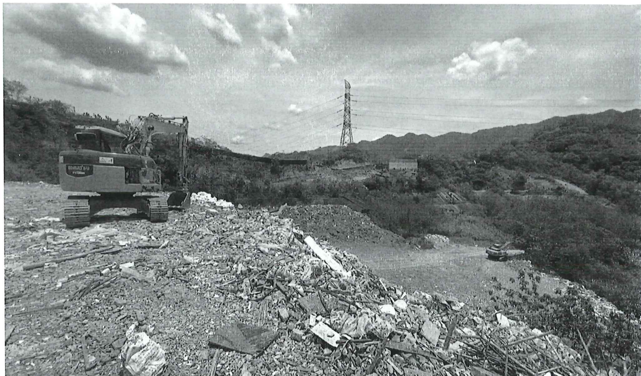
圖 1-4、楠西掩埋場現場混和廢棄物堆置情形
