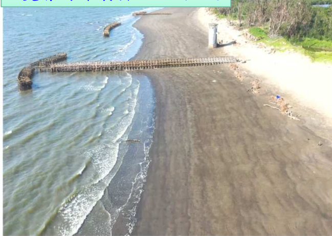
雙春海岸養灘及Nbs突堤
