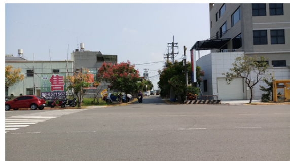
糖鐵與東山三路交叉口現況
