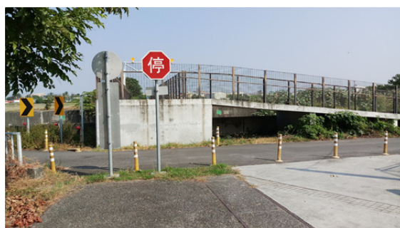
糖鐵與鹽水大排橋墩交叉口現況
