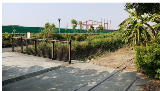
糖鐵過水圳旁之替代道路現況
