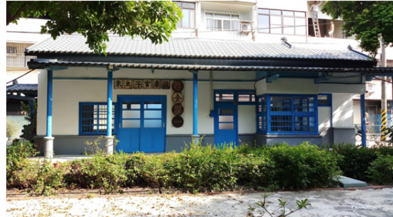
糖鐵【東太子宮車站】現況
