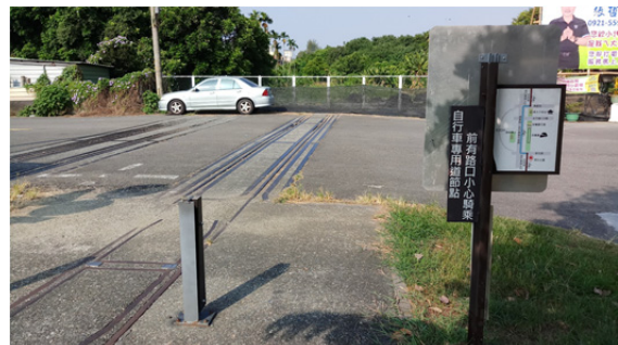
建業路與新生路交叉口現況
