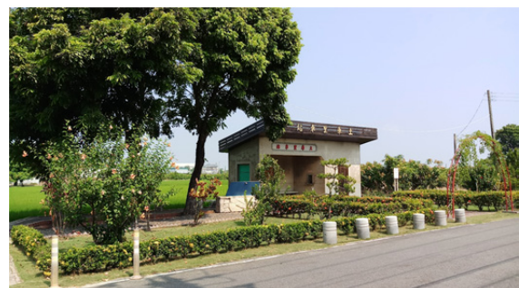
糖鐵【土庫里車站】現況
