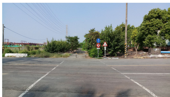
糖鐵與嘉太路交叉口現況
