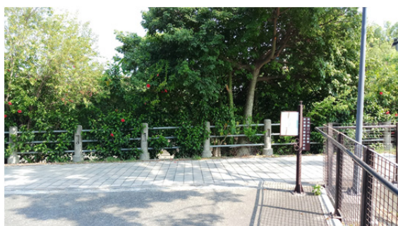
糖鐵與岸內大排橋墩交叉口現況
