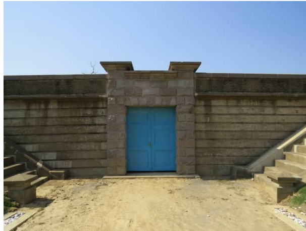
■淨水池背面入口
