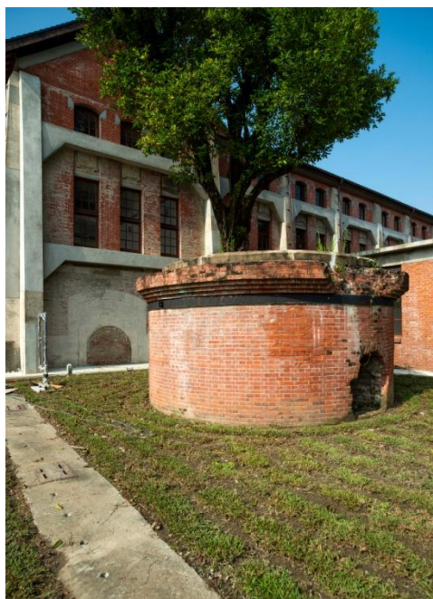
圖片說明：煙囪現況
