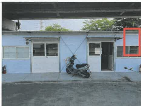
休息室未設置監視設備 ( 3 )
