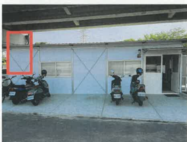
休息室未設置監視設備 ( 5 )
