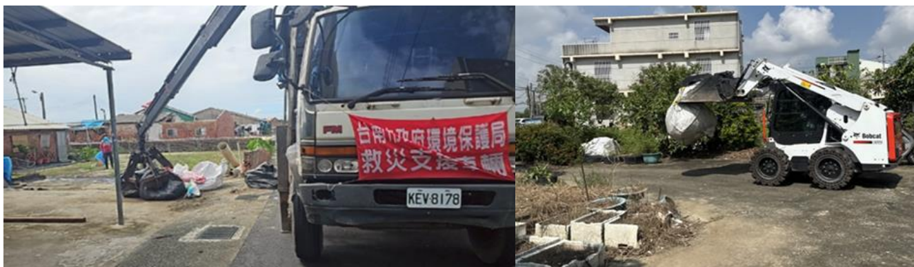
圖 14 石棉瓦清運情形
