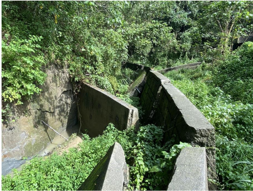
圖 21 丹娜絲颱風龍崎區楠坑里樹子林野溪災後復建工程 18,895 千元
