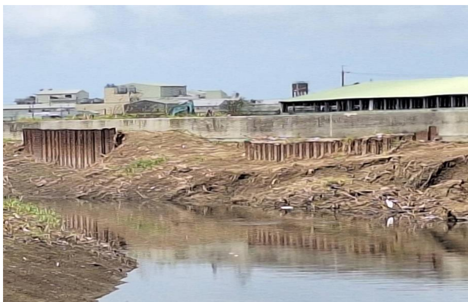
圖 20 丹娜絲颱風鹽水區岸內排水番寮橋下游 350 公尺處右岸護岸災後復建工程 12,322 千元
