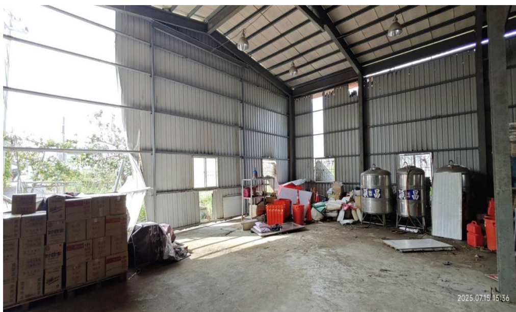
圖 18 北門區防汛倉庫搶修
