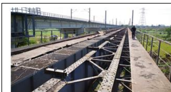
舊鐵路橋現況已無橋面
