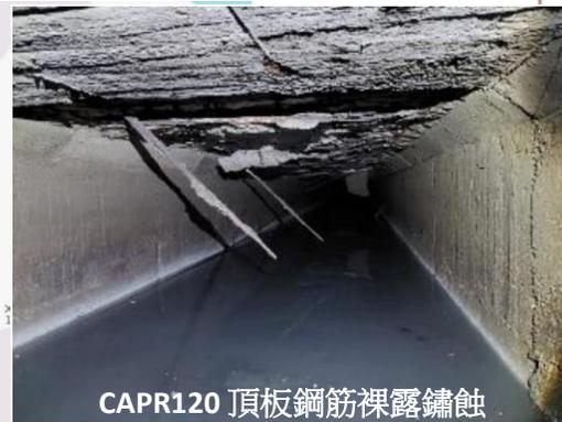
CAPR120 頂板鋼筋裸露鏽蝕
