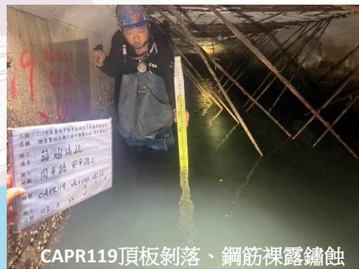
CAPR119頂板剝落、鋼筋裸露鏽蝕
