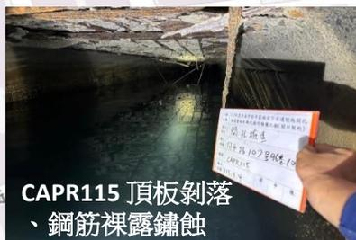
CAPR115 頂板剝落、鋼筋裸露鏽蝕
