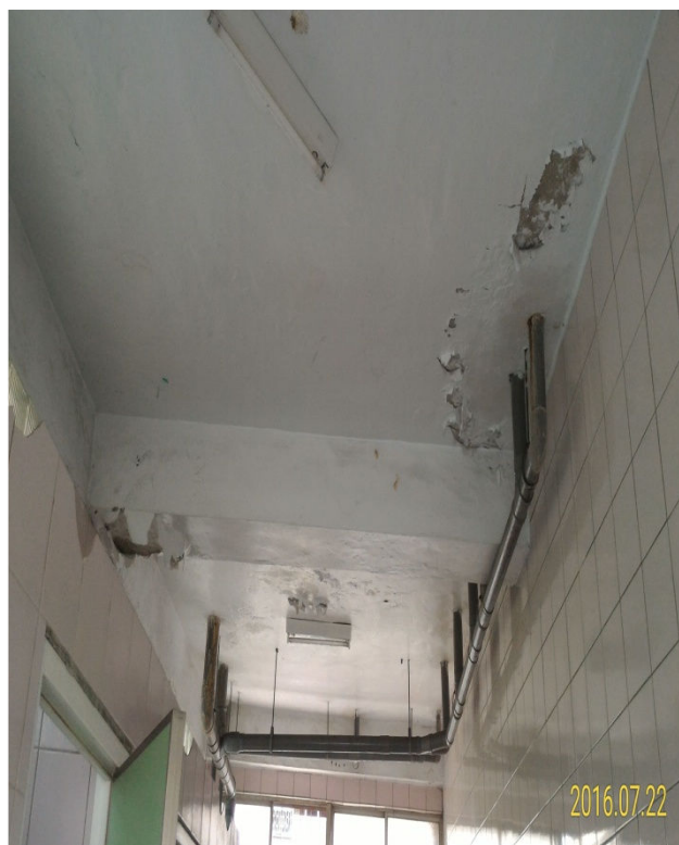
天花板混凝土剝落、樑龜裂及鋼筋外露
