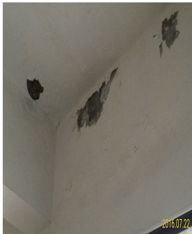
天花板混凝土剝落、樑龜裂及鋼筋外露
