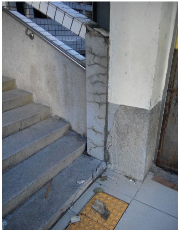
牆面混凝土剝落，鋼筋外露
