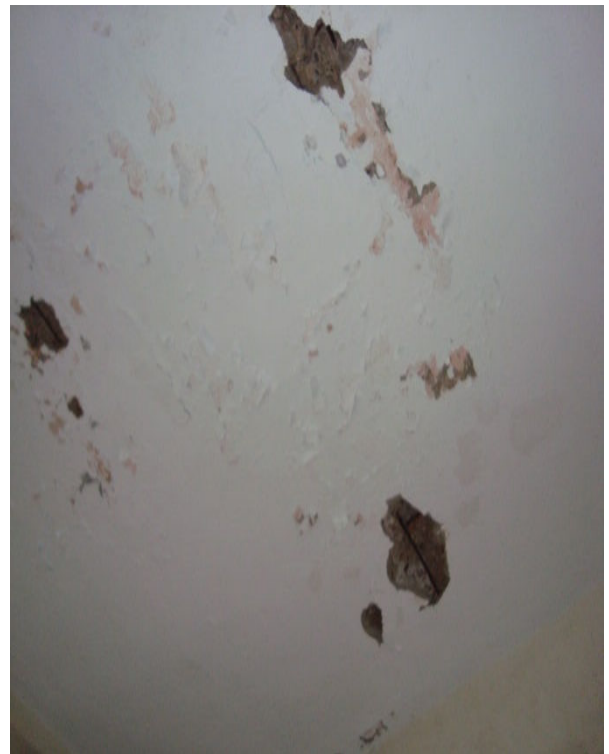
樓梯及結構柱交接處混凝土剝落、鋼筋外露
