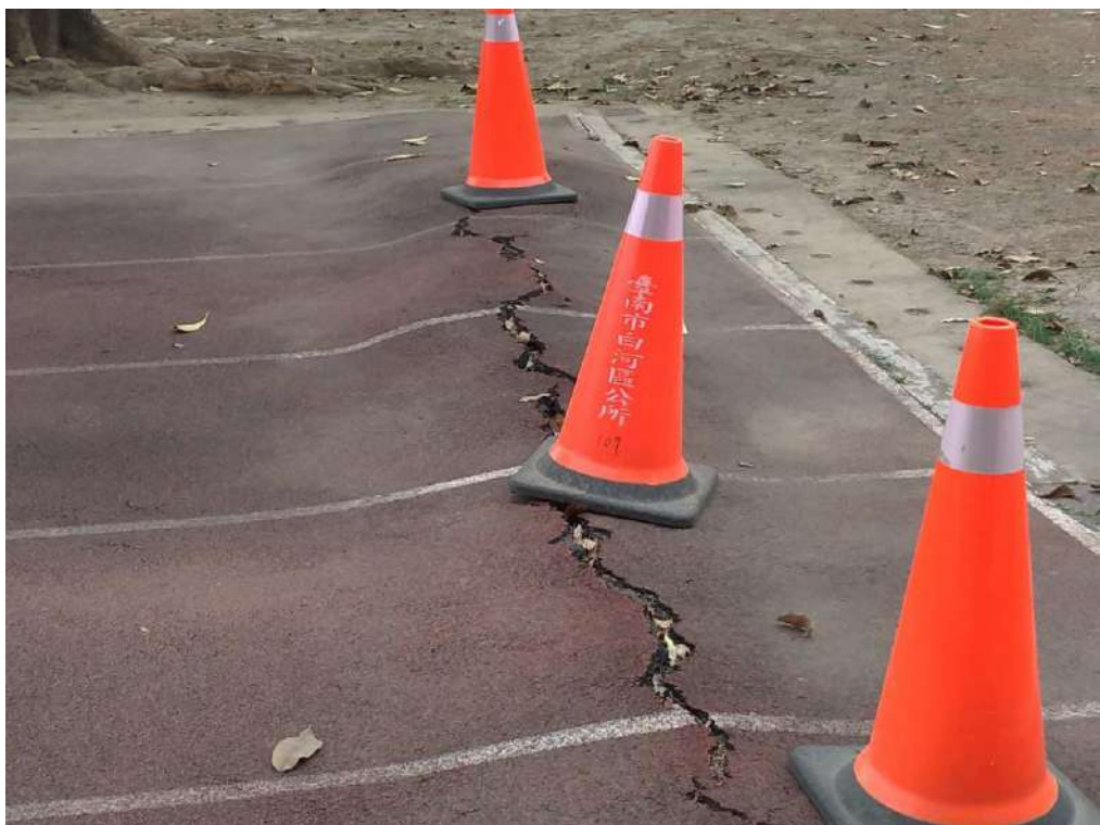
圖：PU 跑道破裂、隆起
