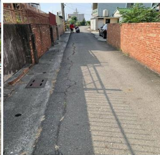
麻豆區港尾里活動中心社區道路改善工程
