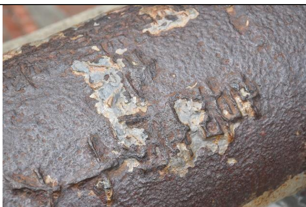
圖 3-3、砲管表面均勻腐蝕
