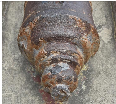
圖 2-4、砲尾腐蝕、保護層老化
