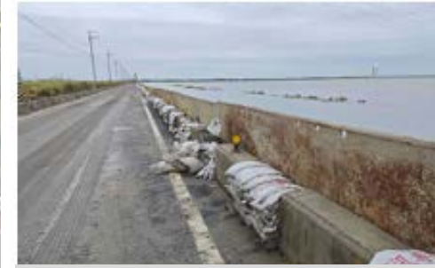
第3道防線路堤加高完成
