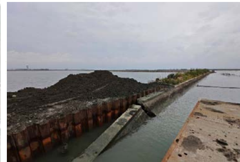
第1道防線搶修完成
