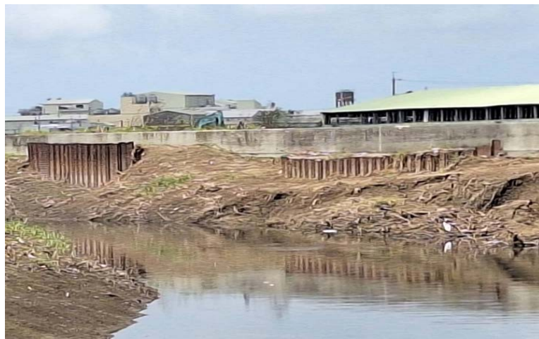
丹娜絲颱風鹽水區岸內排水番寮橋下游350公尺處右岸護岸災後復建工程，提報1200萬元
