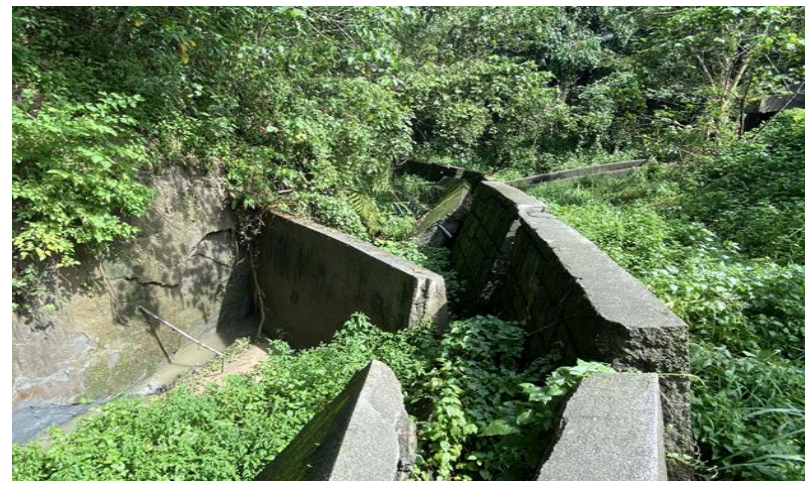
丹娜絲颱風龍崎區楠坑里樹子林野溪災後復建工程，提報1800萬元
