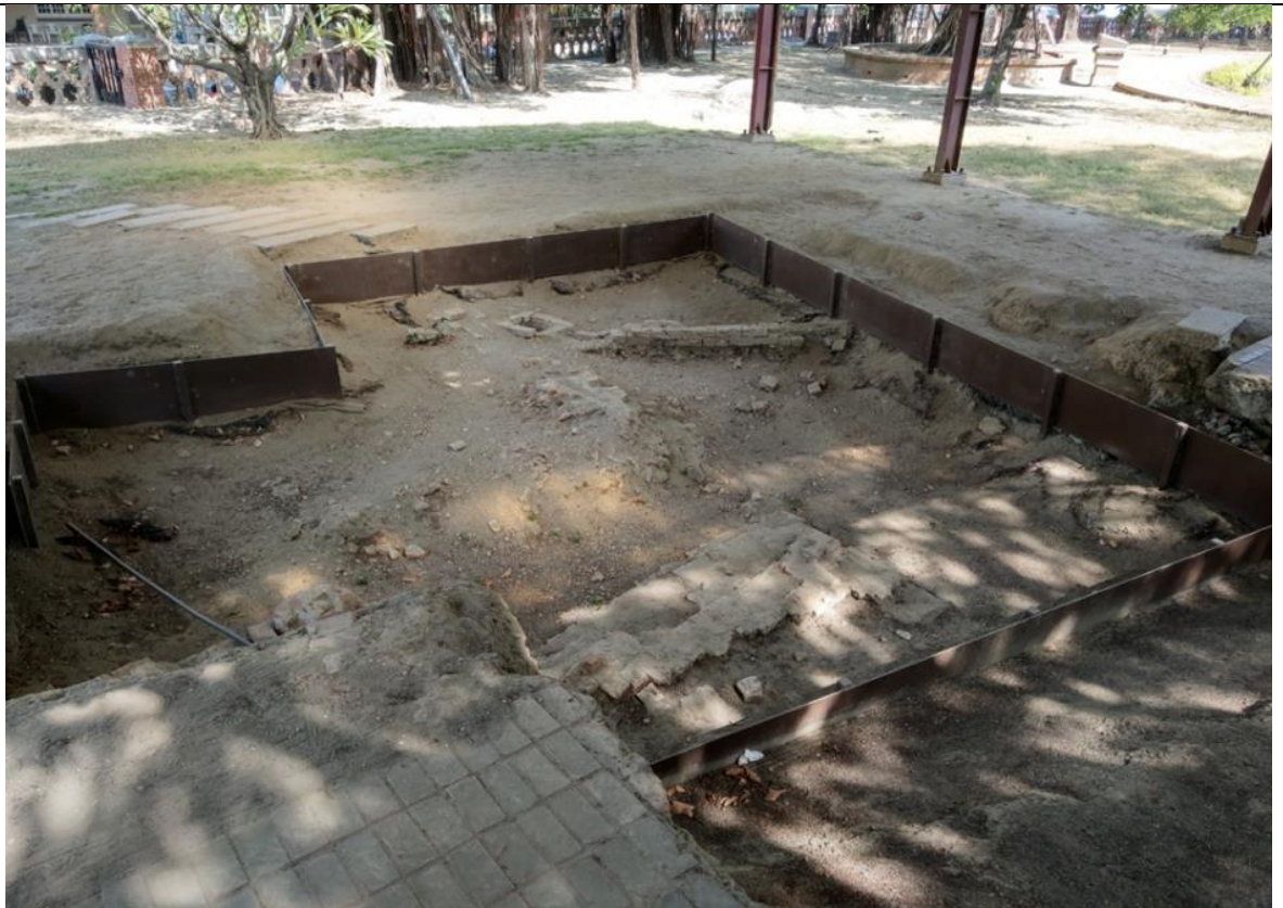
▲TP2探坑現況：許多遺構遭塵土掩埋近半，展示成效不佳。
