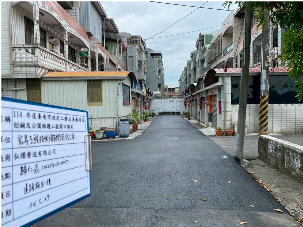
民權六街 161 巷與中山路三段 18 巷完工照片
