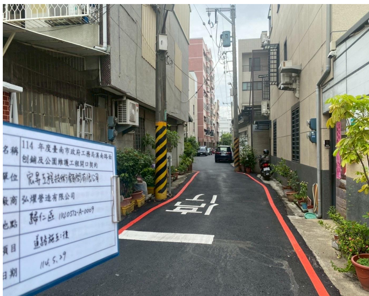
文化三街 18 巷完工照片
