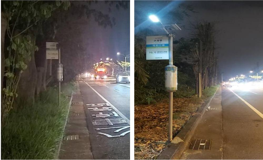
圖 1-2 集中式站牌建置太陽能照明設備示意圖
